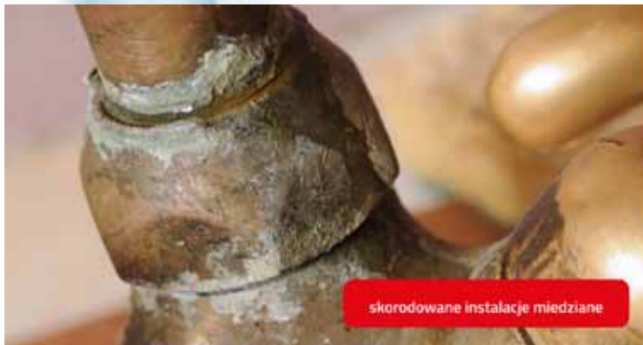
osad i korozja na zlewie
